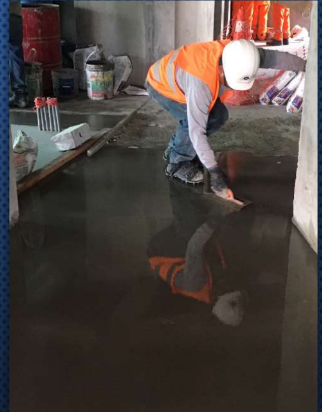
NIVELACION DE PISOS CON AUTONIVELANTE NOVOPLAN 2 PLUS
