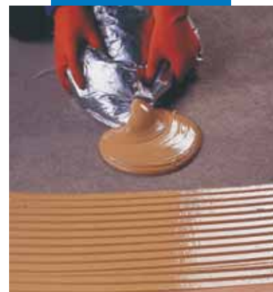
Ecurrido del adhesivo en el ángulo inferior
