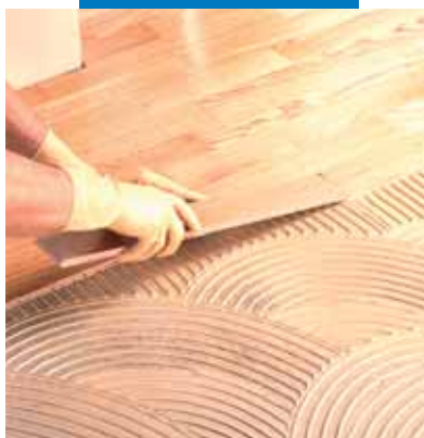
Colocación del parquet
